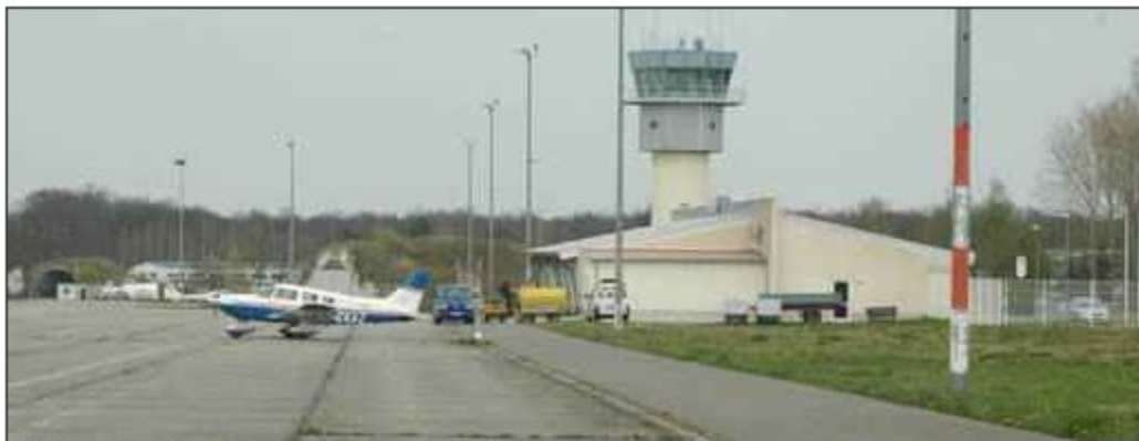
Flugplatz Altenburg-Nobitz mit Abfertigungshalle
